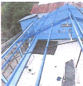
Foto 3: ESTRUCTURA DE TECHO Sustrucción de estructura de techo en áreas de los baños, área de pila y comedor.
