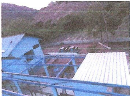
Foto 1: CUBIERTA DE LÁMINA Sustrucción de techo de lámina en mal estado por lámina troquelada calibre 26 en el área de los baños, área de pila y comedor. Sustrucción de
