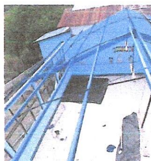
Foto 4: Mantenimiento a estructura metálica en el área de las aulas (lijado y pintura).
