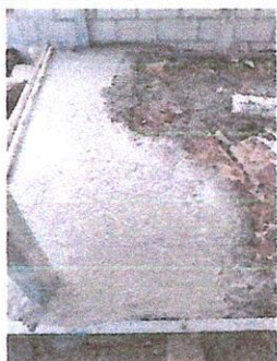
Foto 5: LOSA DE PATIO Reparación a losa de concreto en mal estado en patio, de un espesor de 8.00 cm.
